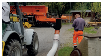
Hochwasserschutz: Befüllung von Sandschläuchen und Sandsäcken (Schaufel 1,0 m³ mit Einfülltrichter)
