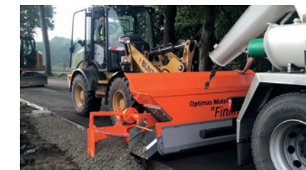
Bau von Randeinfassungen (1,0 m³ mit Materialrutsche, kurz und Abziehschild Stahl)
