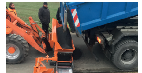
Die Schaufel wird direkt vom LKW befüllt
