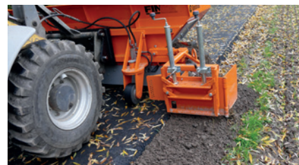
Verteilung von Schotter/Splitt im Bankettbau (Schaufel 1,4 m³ mit Abziehschild Stahl)
