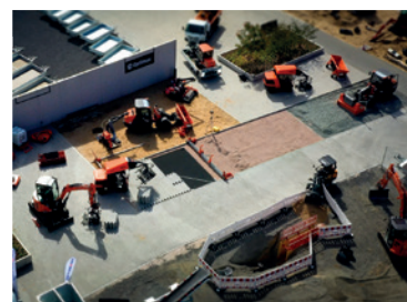
Musterbaustelle im Coreum, Stockstadt a. R.
