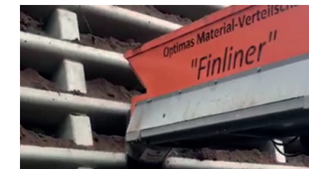
Befüllen Lärmschutzwand (Schaufel 1,0 m³ mit Materialrutsche, kurz)
