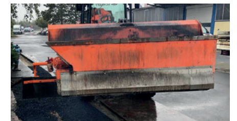
Asphalteinbau (Schaufel 1,0 m³ mit hitzebeständigem Förderband und Abziehschild, Gummi)
