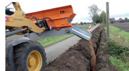
Absanden von Gräben und Leitungen (Schaufel 1,0 m³ mit Materialrutsche lang)
