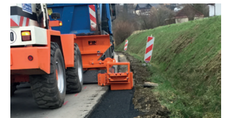
Materialverteilung: Abziehen mit Abziehschild Stahl (Schaufel 1,0 m³)
